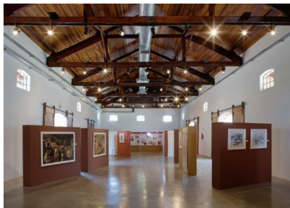
Figura 7. Vista interna, detalhe do madeiramento da cobertura.
