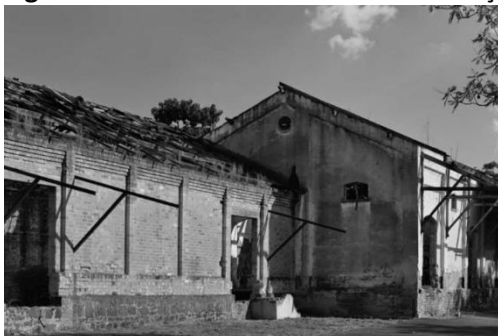
Figura 2. Foto do local antes da intervenção
