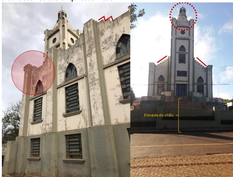
Figura 6. Igreja IPI e as características arquitetônicas.
