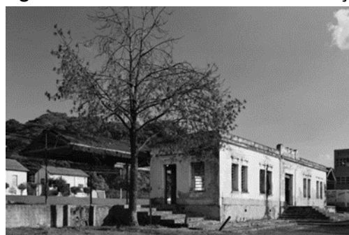
Figura 3. Foto do local antes da intervenção
