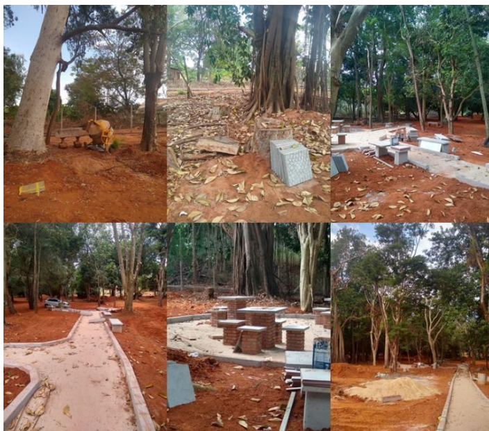
Figura 22. Obras de Revitalização no Bosque
