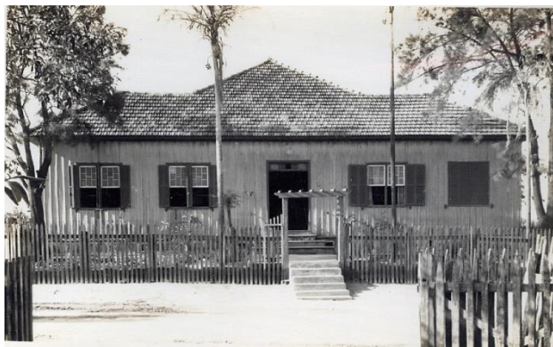
Figura 02. Primeira escola instalada na cidade de Tarabai.
